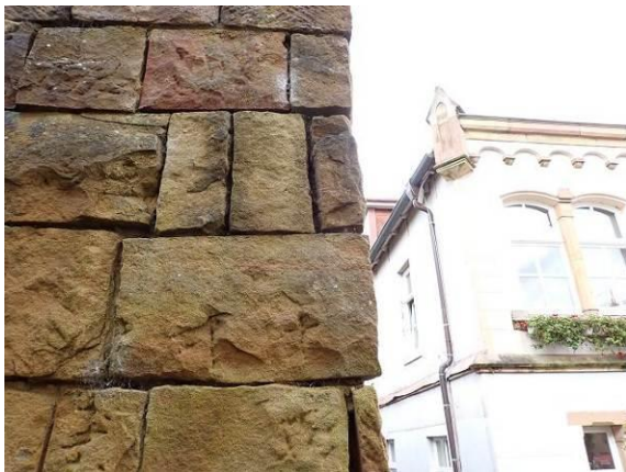
Dünnschaliges Steinmaterial auf „Spalt“ gesetzt
