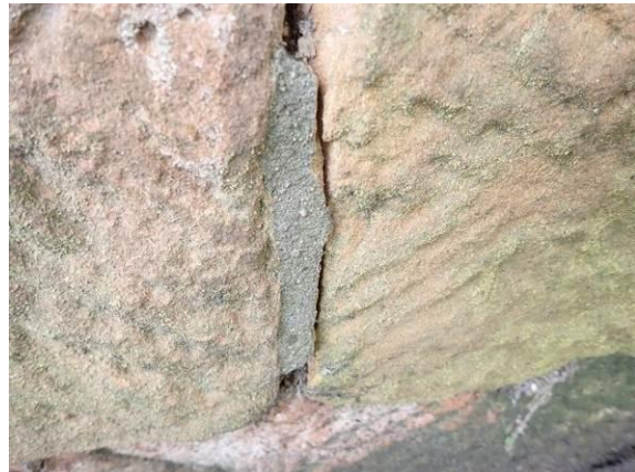
Flankenabriss im Detail
