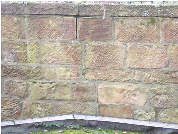
Teilbereich mit zementgebundenen Deckfugen
