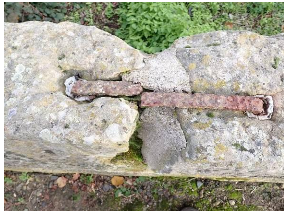
Geschädigte Verklammerung
