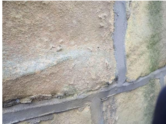
Profilierte zementfuge im Detail
