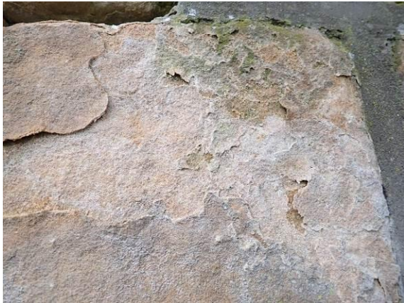
Abspregung einer Sinterkruste
