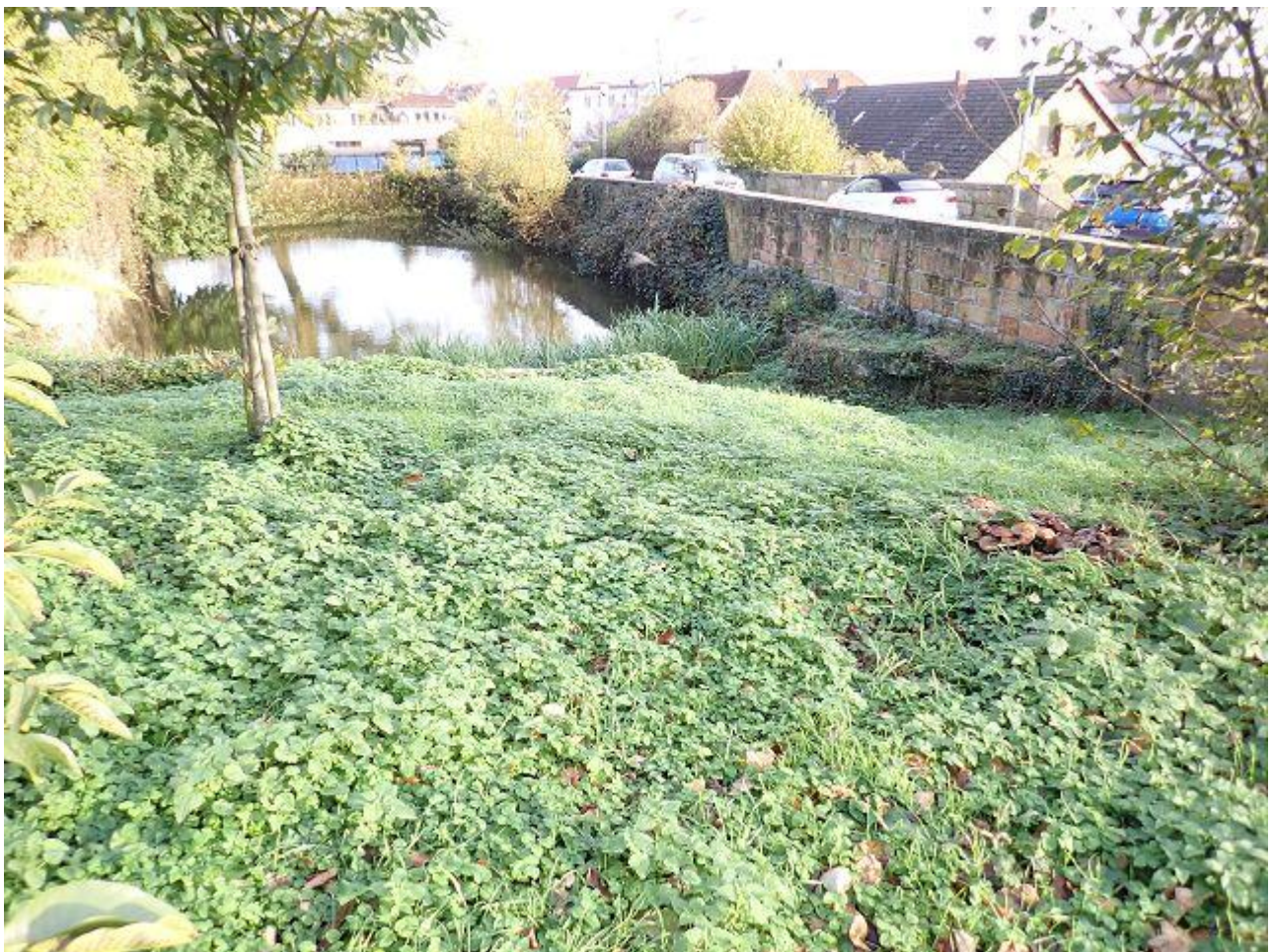
Einfriedungsmauer Teich, Südwall, Oktober 2025
