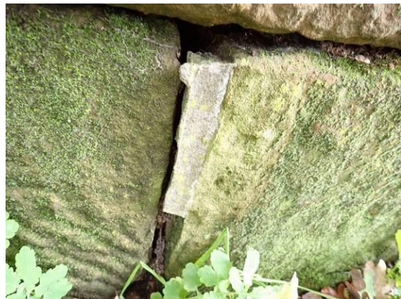
Geschädigtes Mauerwerksgefüge
