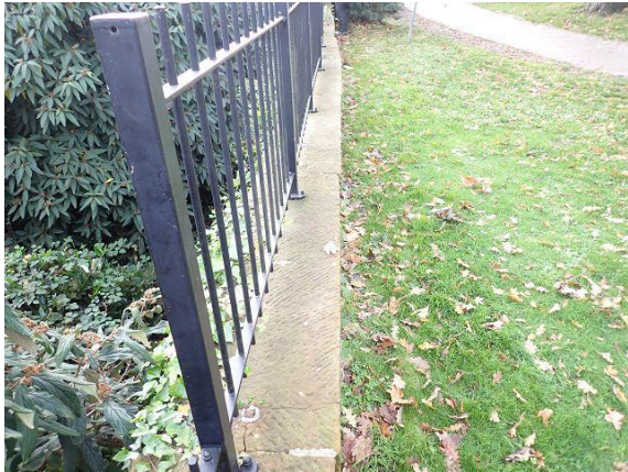
Verformte Zaunanlage
