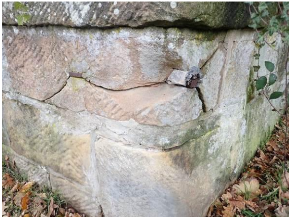
Teilansicht Ecke Südost, Teicheinfriedung
