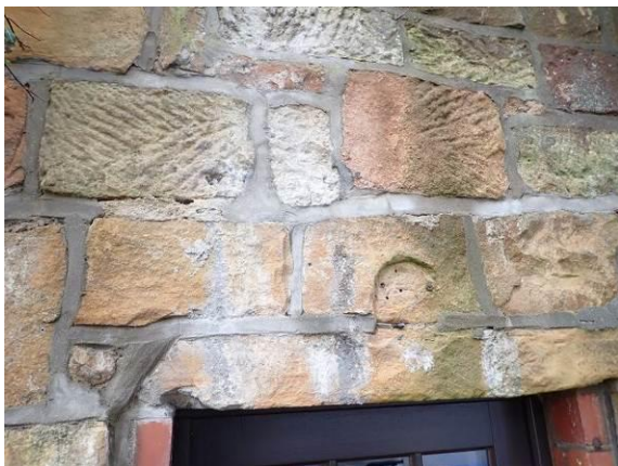
Detail Bindemittelauswaschungen
