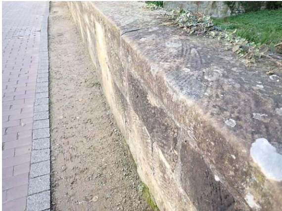
Teilbereich der Teicheinfriedung
