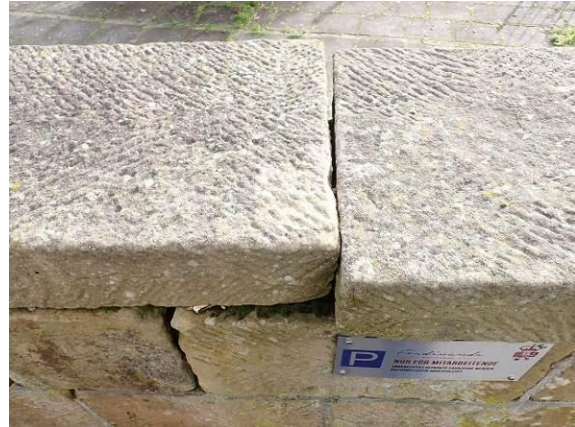
Verschobenen Abdeckplatten
