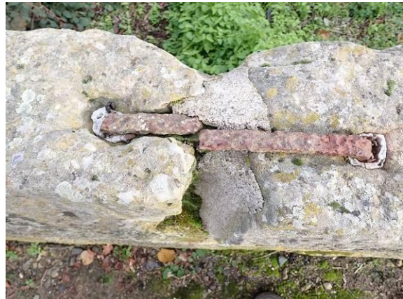
Geschädigte Verklammerung
