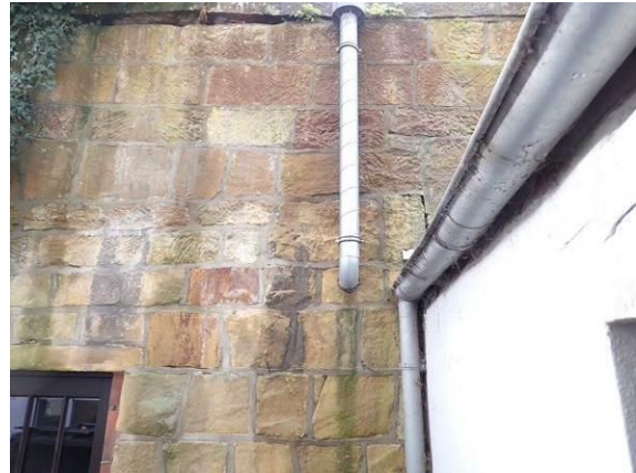
Bindemittelauswaschungen im Detail
