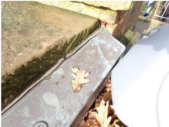
Abdeckung Bestandsmauerwerk im Detail
