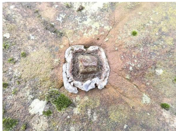
Weitere Korrosionssprengung
