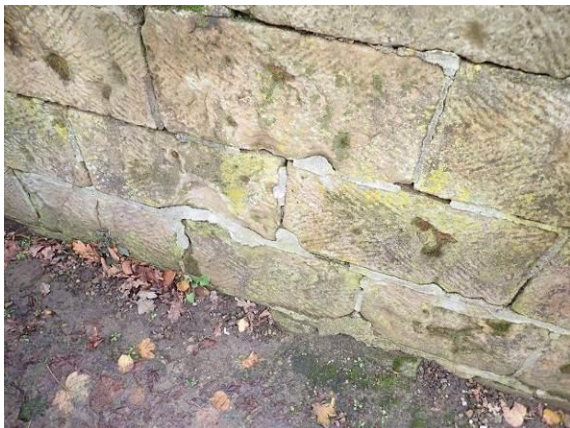
Geschädigte Reparaturverfugung
