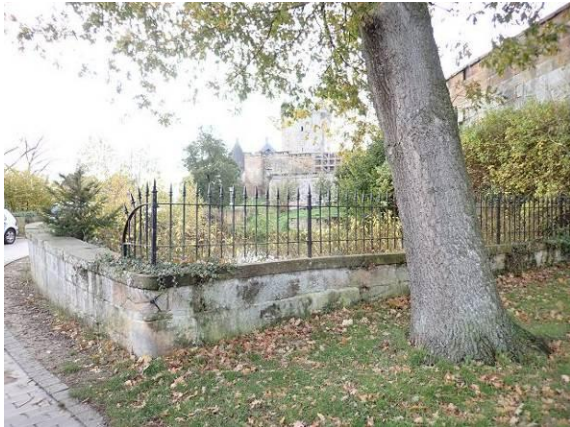
Baumbewuchs an der Teicheinfriedung
