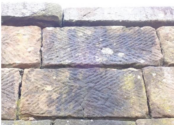
Fehlende Abtropfmöglichkeiten
