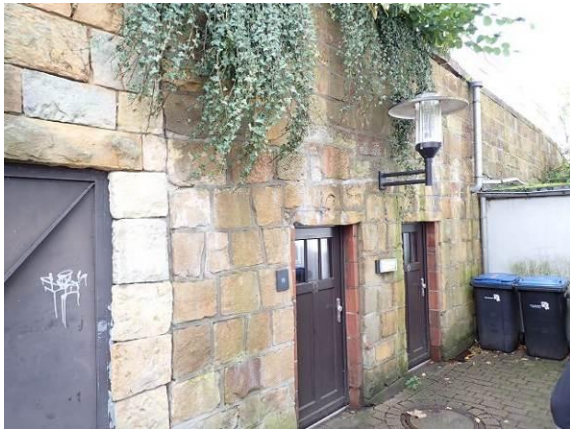
Überformte Außenschale als Mauerwerksverblendung
