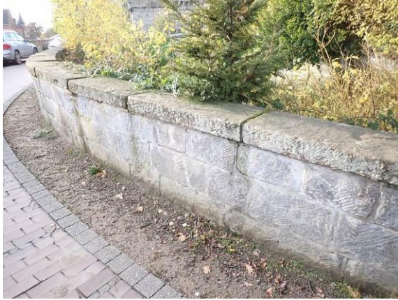
Teilbereich der Teicheinfriedung
