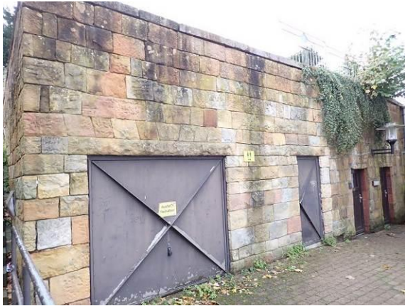
Südlicher Bereich als Verblendschale
