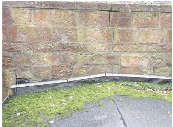
Dachanschluss am Anbau
