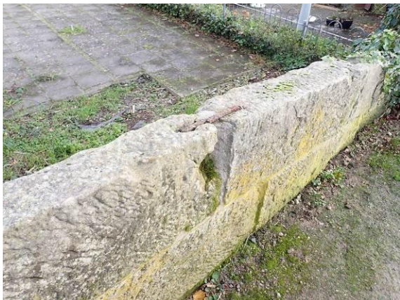
Schildwand als einschalige Konstruktion
