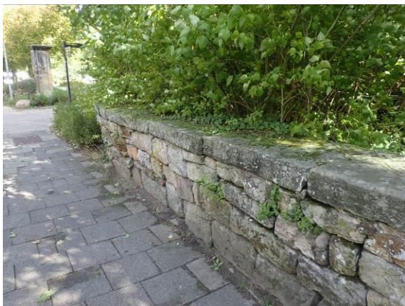
Verformte Westwand
