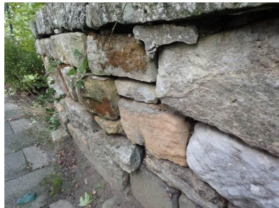
Zustand im Detail
