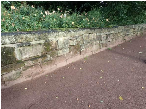
Teilbereich der Ostwand
