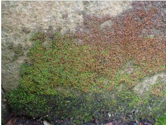
Materialabbau durch Biokruste
