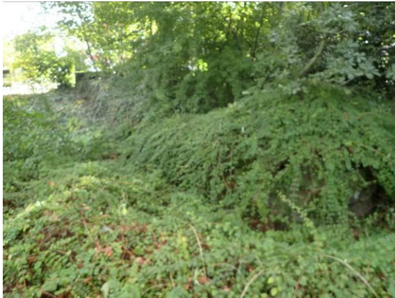
Überwachsene Trockenmauer, Südwand
