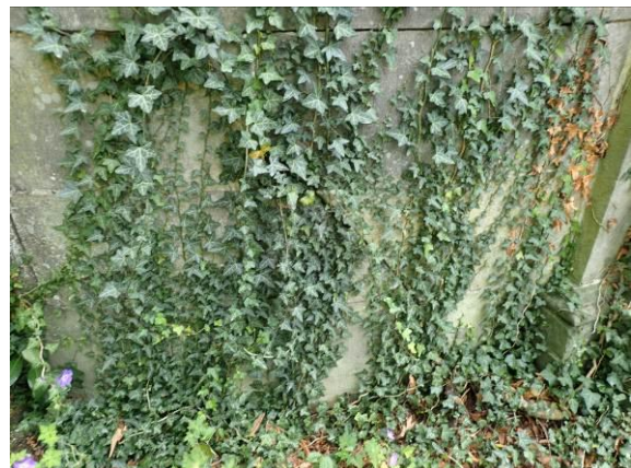
Zustand auf der Westoberfläche
