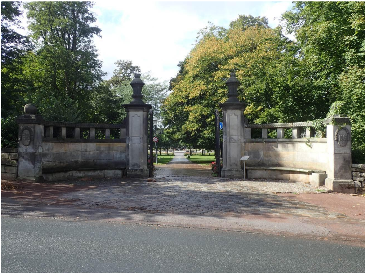
Einfriedungsmauer, Schlosspark, Ansicht Kaisertor Ost, September 2025
