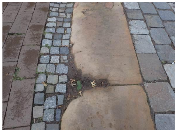
Geschädigte Schwelle
