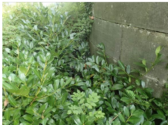
Zustand im Detail
