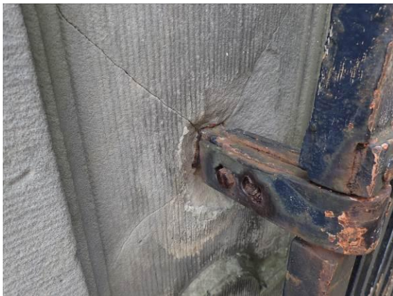
Weitere Steinsprengung im Detail
