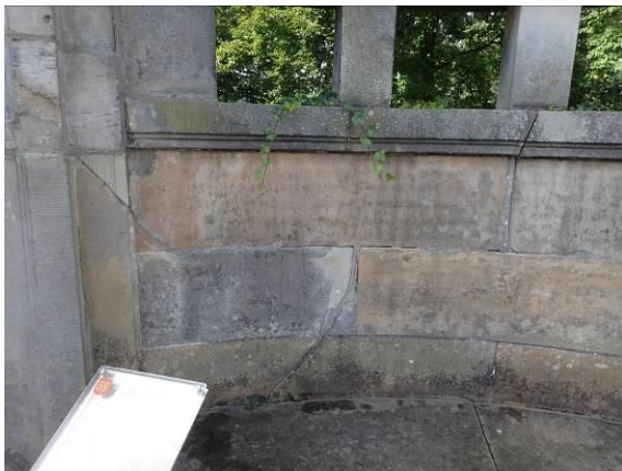
Rissbildung Südflügelmauer zum Pfeilermauerwerk
