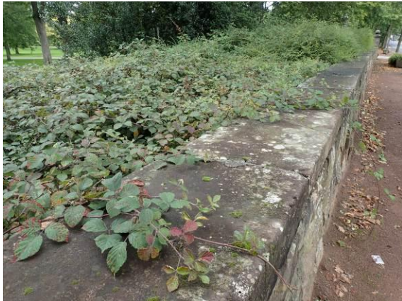
Mauerkronenabdeckung der Westwand
