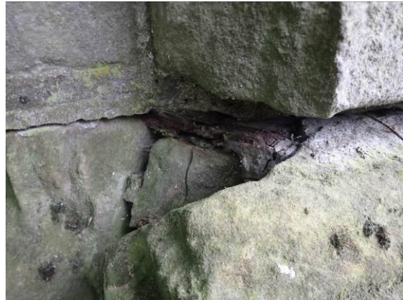
Geschädigte Verklammerung
