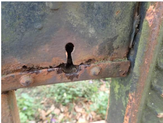
Zustand am Schlosskasten
