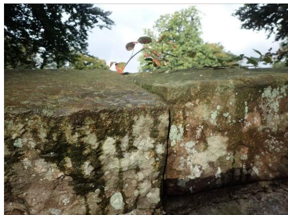
Weitere Verformung im Detail
