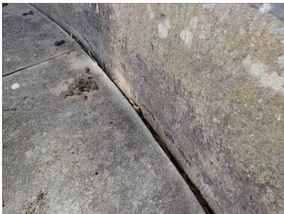
Abriss Wand von der Sandsteinbank
