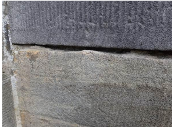
Geschädigte Verfugung
