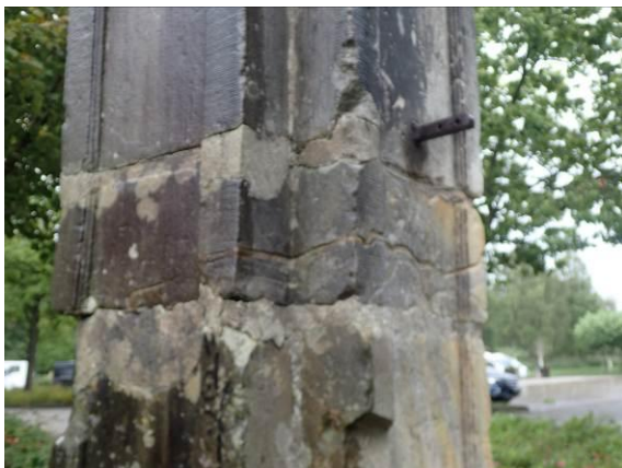
Reparaturversuch am Westtorfeiler
