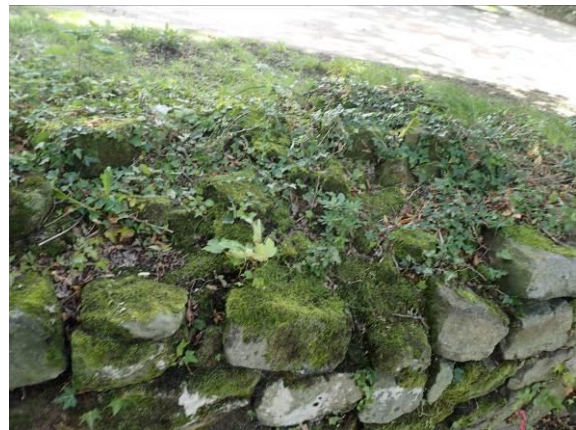
Geschädigte Mauerkrone
