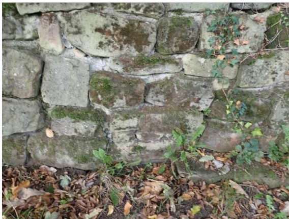
Plombenwirkung durch Vermörtelungen
