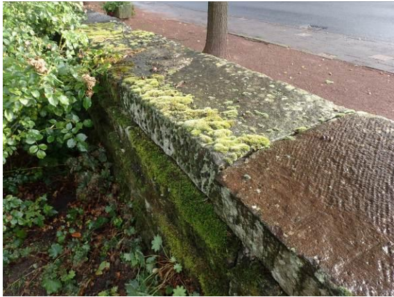
Unterschiedliche Geländehöhen, Ostwand
