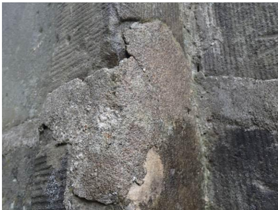
Reparaturversuch an der Wandverklammerung
