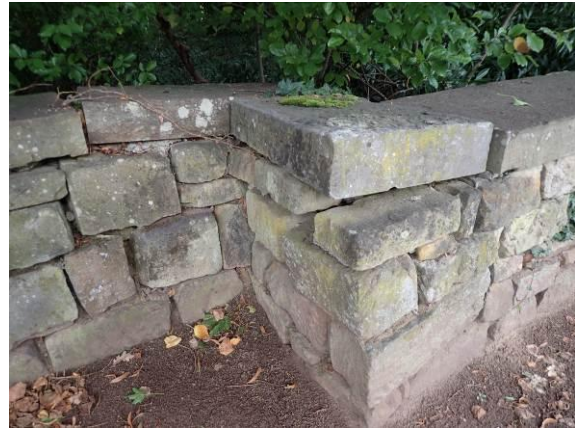
Weiterer Gefügeschaden
