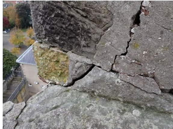
Gelöste Mauerschale
