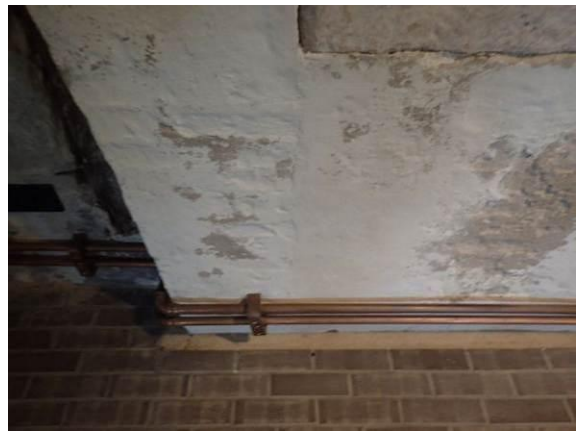
Schadsalzschaaden im Detail
