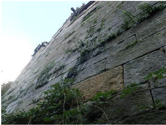
Teilbereich der Westfassade
