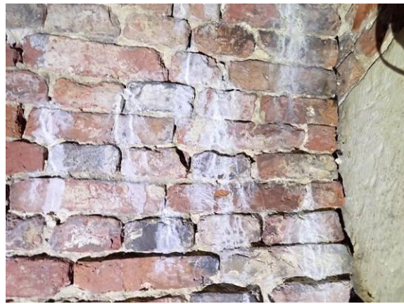
Bindemittelauswaschungen im Detail
