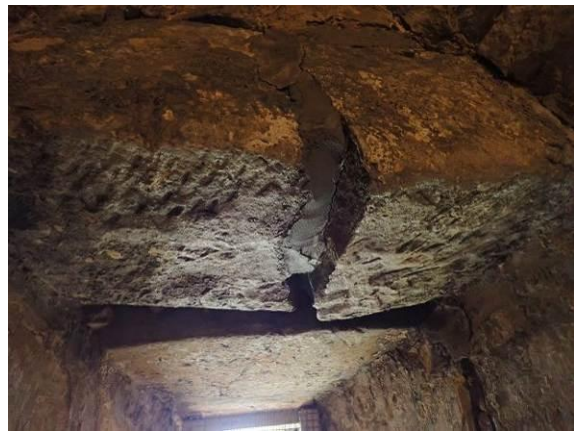
Gebrochener Sturzriegel
