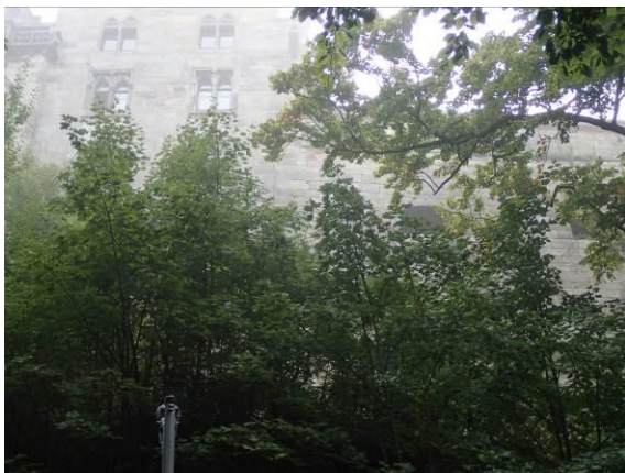
Buschwerk im Bereich der Westfassade
