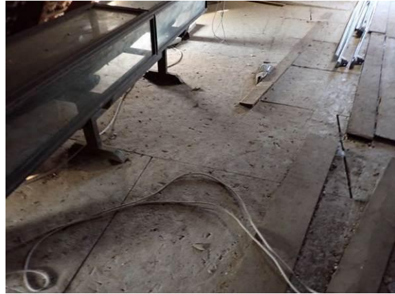
Plattenbelag im Detail
