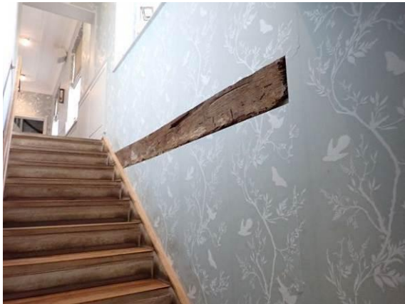
Streichbalken Nord, Decke über dem Erdgeschoss
