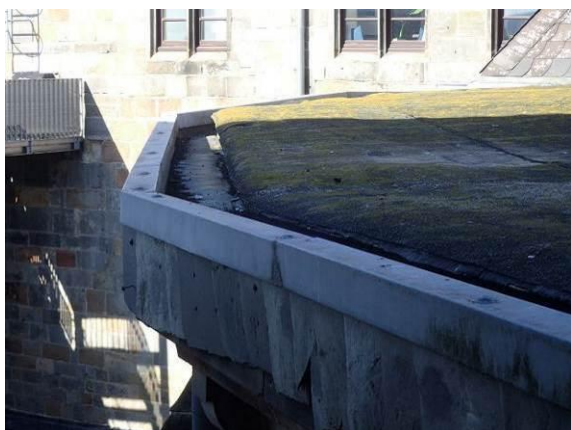
Verformte Dachhaut
