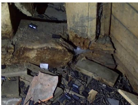
Schädigung Sparrenfuß
