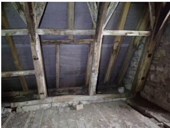
Dachtragwerk im Nordflügel
