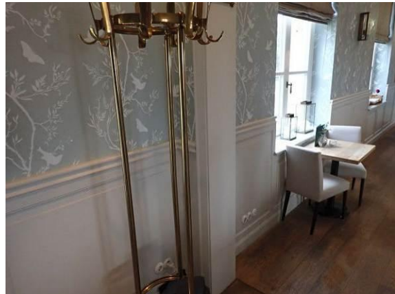
Sockelverkleidung im Obergeschoss
