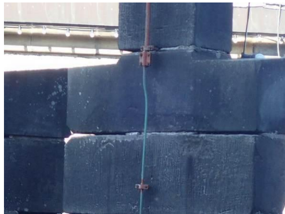
Zustand der Zinnen, Ostfassade
