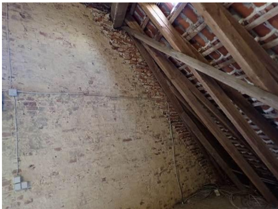
Teilbereich des Westgiebels
