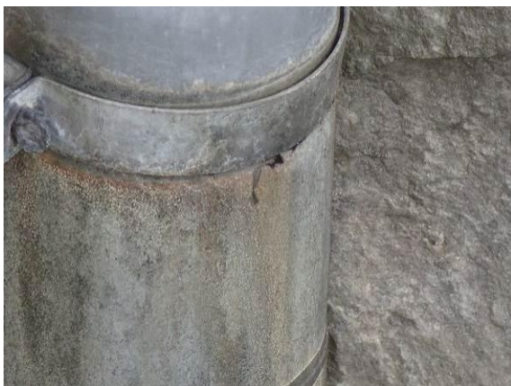
Undichtes Fallrohr
