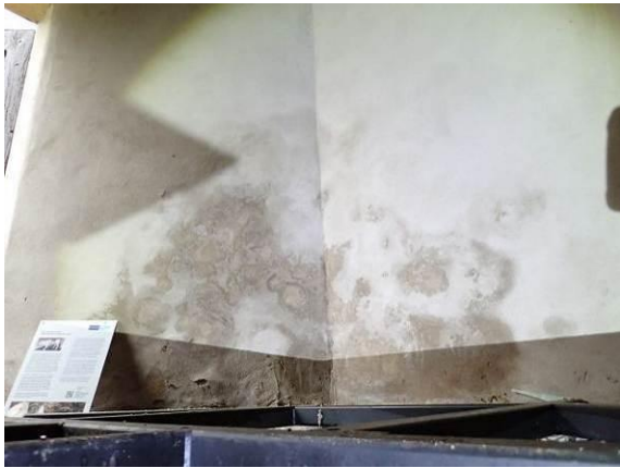
Teilansicht Nordwand, Ziegelmauerwerk
