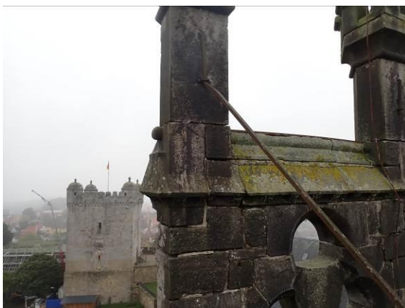
Fallsicherung durch Giebelanker
