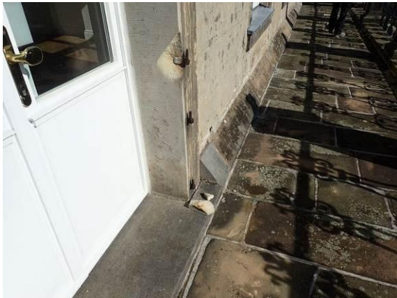
Gewände der Südfassade
