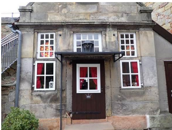
Südansicht des ehem. Kassenhauses
