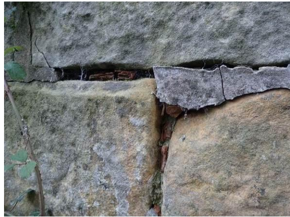
Abgängige Reparaturverfugung
