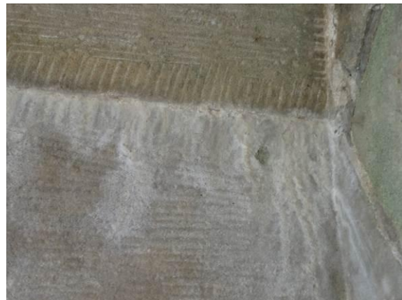
Bindemittelauswaschungen im Detail
