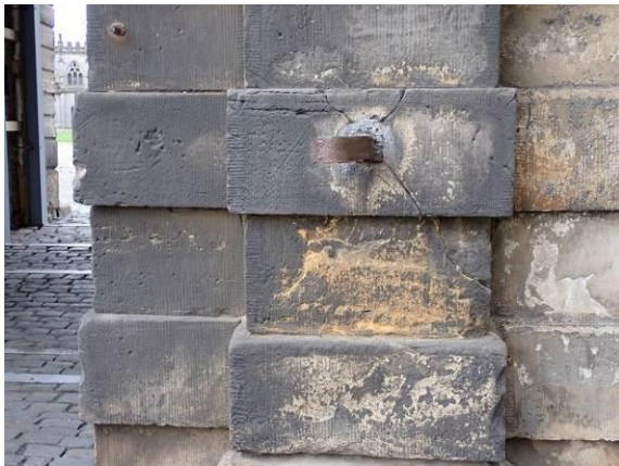
Anker in der Ostfassade
