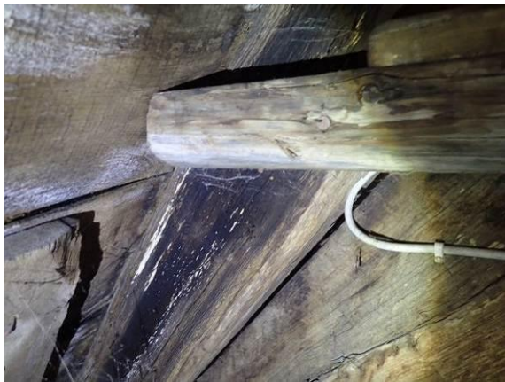
Undichte Dachhaut
