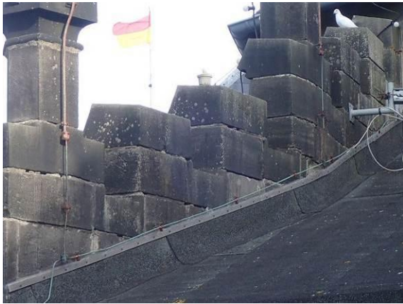
Zinnen der Ostfassade
