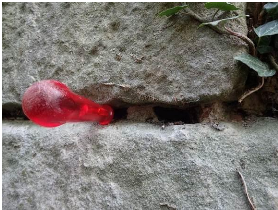
Geschädigter Setzmörtel
