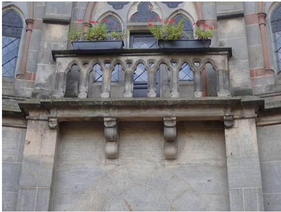
Ansicht Balkon Ost
