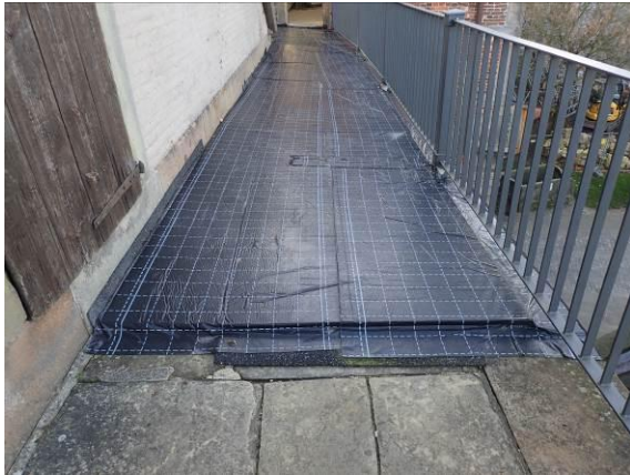
Provisorische Abdeckung des Wehrgangs
