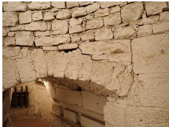
Gefügelockerung im Detail
