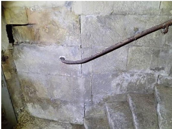
Teilbereich des Handlaufs
