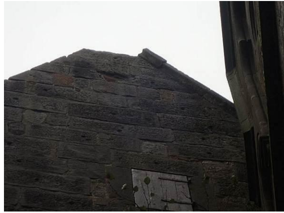
Fehlende Abdeckplatten
