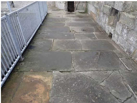
Verformter Belag des Platon
