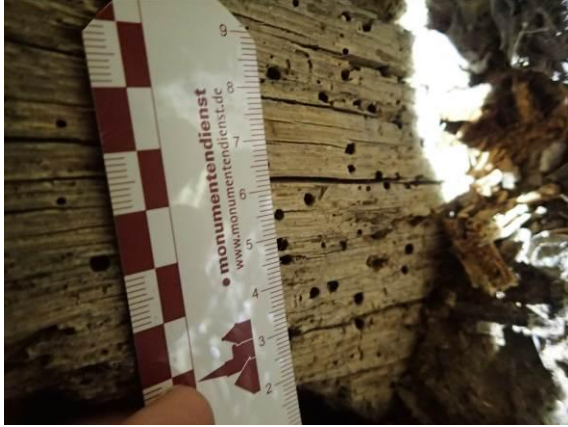
Ausflugslöcher Deckenbalken, Südflügel
