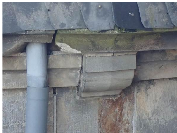
Undichter Fallrohranschluss
