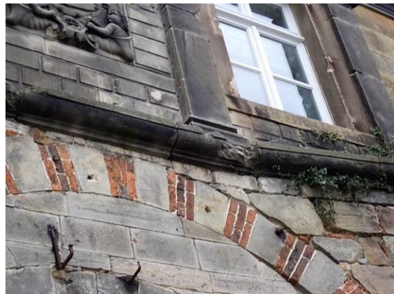
Krustenbildung auf den Werksteinbeständen
