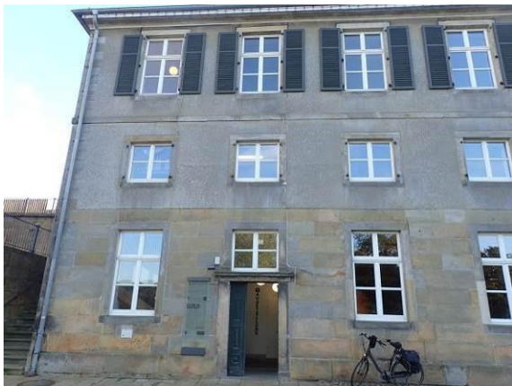
Fensterachsen der Nordfassade
