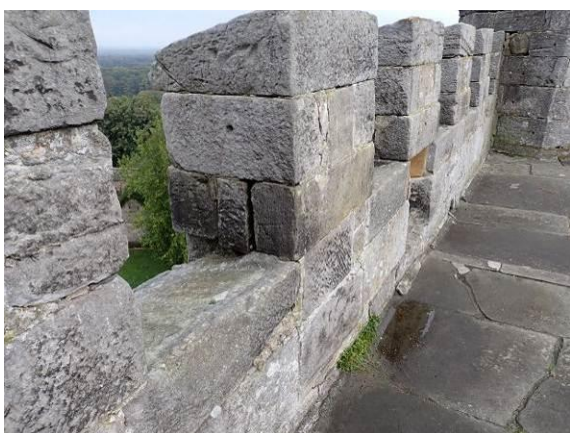
Verformter Zinnenkranz
