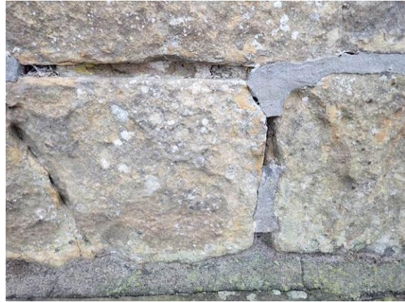
Geschädigte Deckfuge
