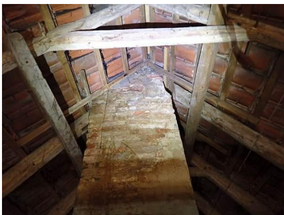
Sparrenanschluss zum Schornstein
