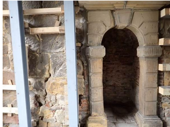
Schalenmauerwerk als Gewölbewiederlager
