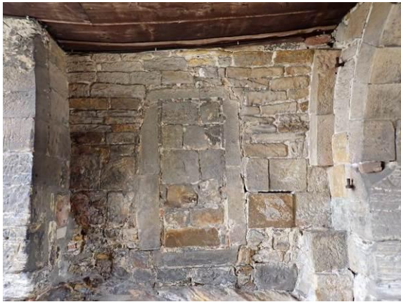
Teilbereich der Wiederlagerwand
