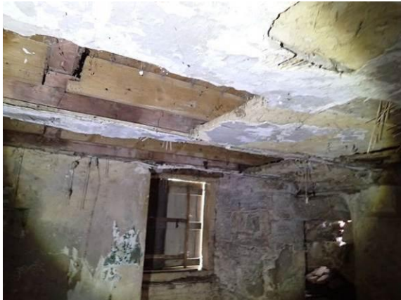
Untersicht Decke im Nordflügel
