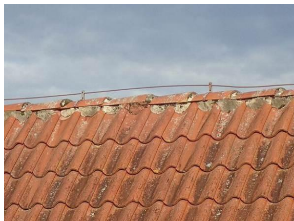
Geschädigter Mörtelfirst
