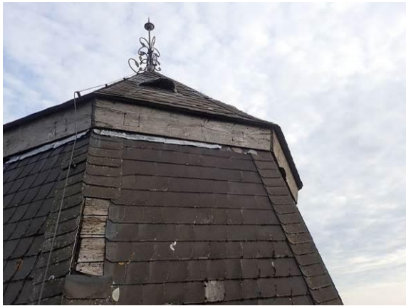
Bleichsürze zum oberen Turmhelmteil
