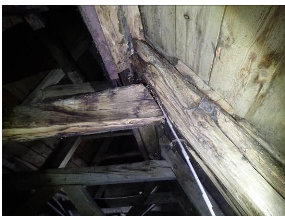
Geschädigter Rähmanschluss
