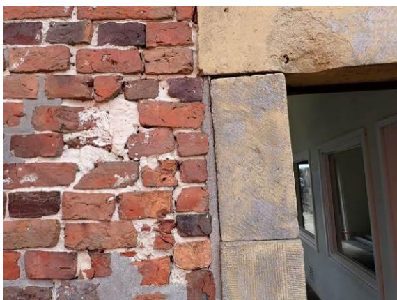
Gelockerter Gewändestein
