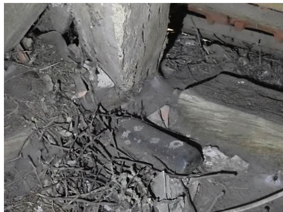
Verformung im Schwellenkranz
