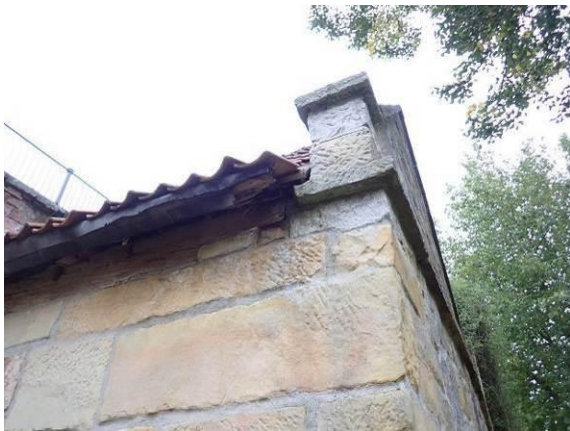
Fehlende Dachentwässerung
