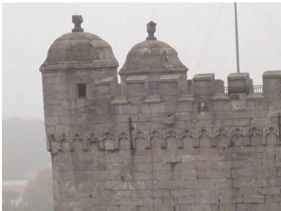
Verformte Wacherker
