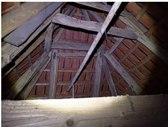
Teilbereich des Dachtragwerkes
