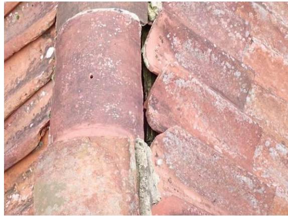
Zustand im Firstbereich
