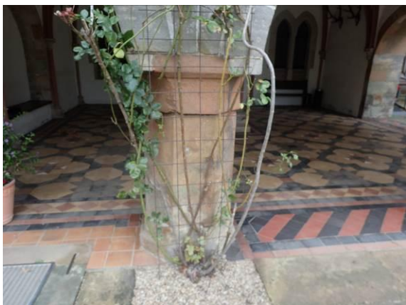
Pfeiler der Ostfassade, Südflügel
