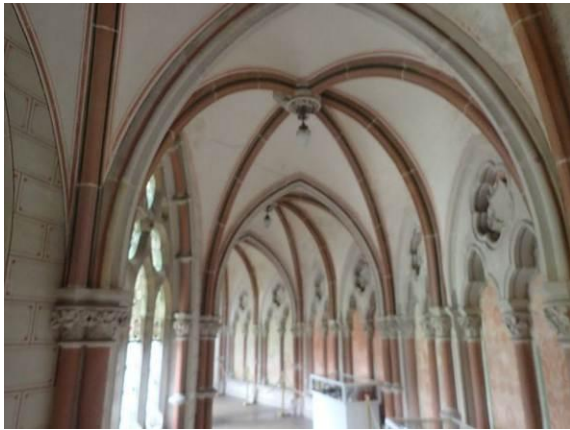
Teilansicht Innenraum im ersten OG
