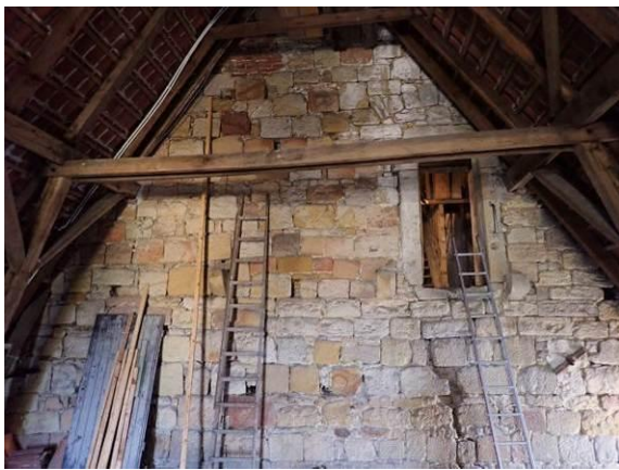
Teilansicht West, Turm
