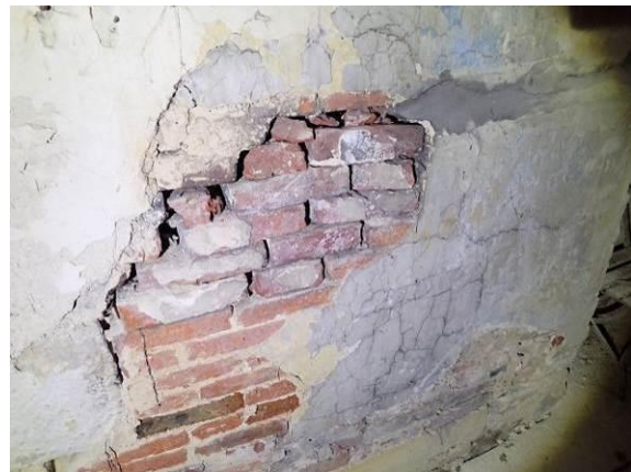
Zustand an einer Reparaturstelle
