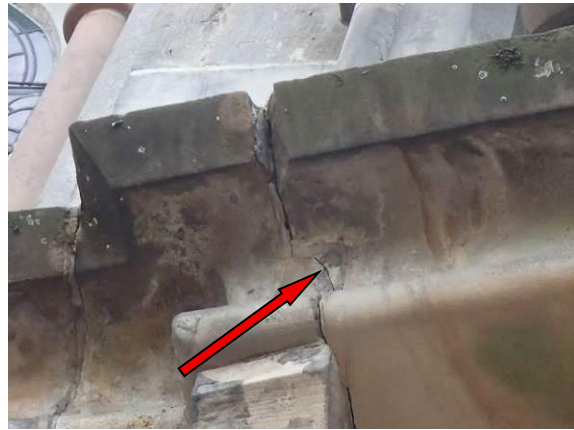
Ausbruch am Auflagerstein
