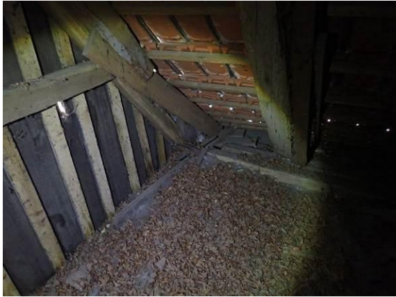
Teilansicht Decke über dem ersten OG
