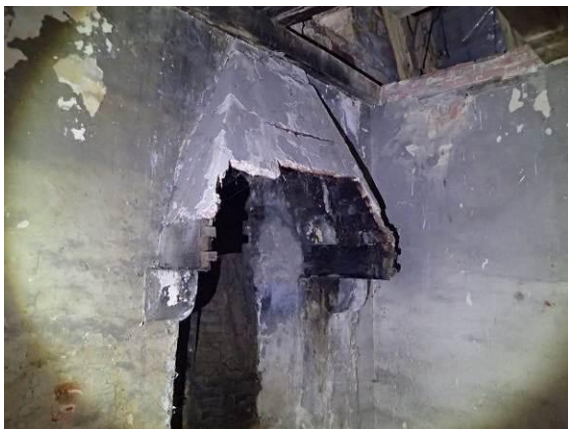
Abgängiges Boosenmauerwerk
