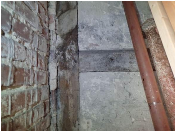
Teilbereich Trennwand der Werkstätten
