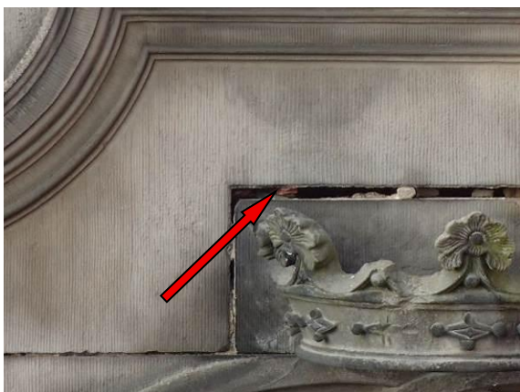
Korrosion Halteanker
