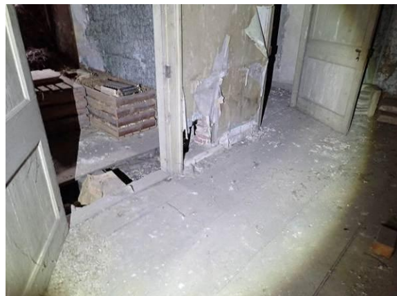
Ablastung im Detail
