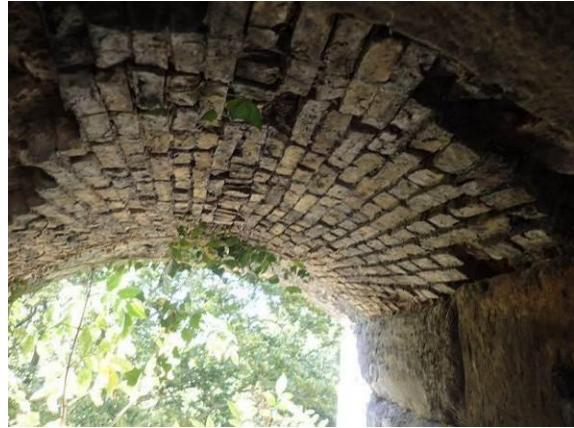
Geschädigtes Kappengewölbe
