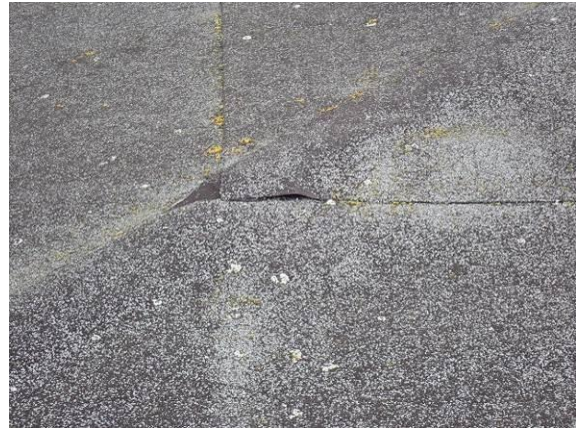
Geschädigter Schweißnaht
