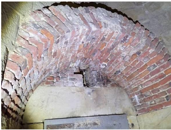
Bogenmauerwerk an der Ausfallpforte
