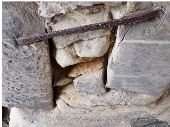
Geschädigter Schalenanker
