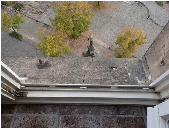
Gebrochener Brüstungsriegel
