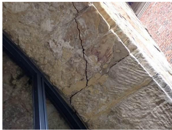
Abriss der Außenschale
