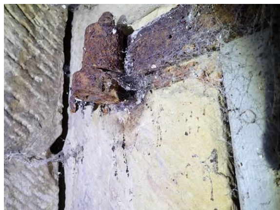
Korrodierter Kloben
