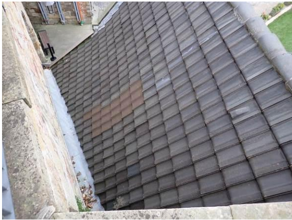
Teilansicht Dachfläche Ost
