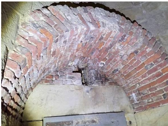
Bogenmauerwerk an der Ausfallpforte
