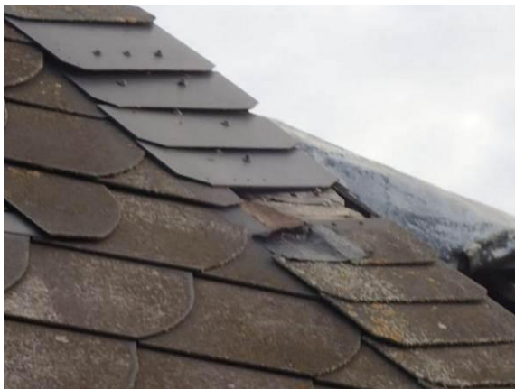
Gelöste Reparaturplatten
