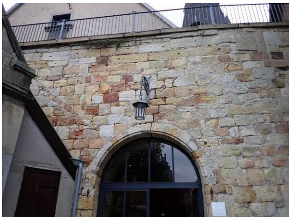
Teilbereich der Westfassade
