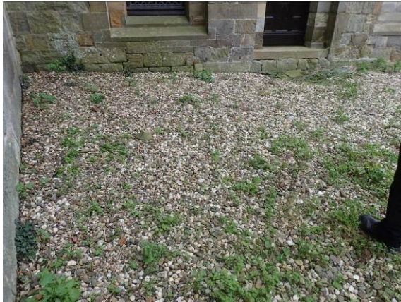
Sockelbereich der Nordwestterrasse
