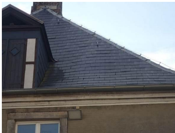
Verformung Dachfläche
