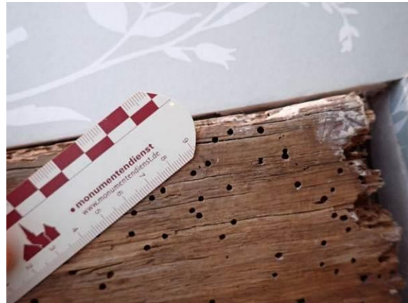
Ausflugslöcher im Detail
