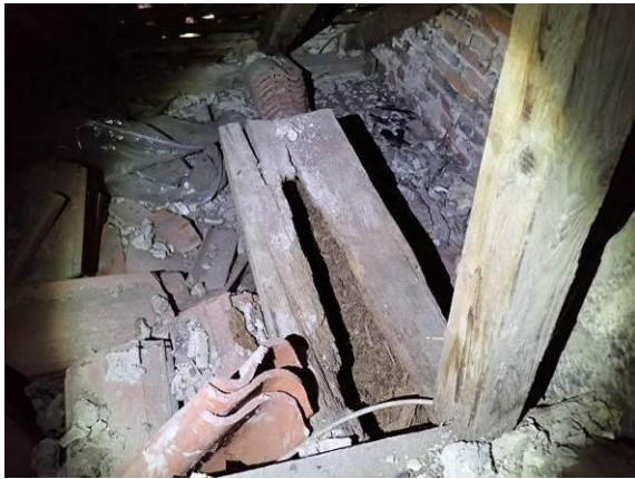
Deckenbalkenaufleger Nord, Schiff
