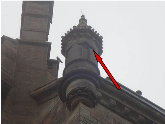
Korrosionssprengung Giebelbekrönung
