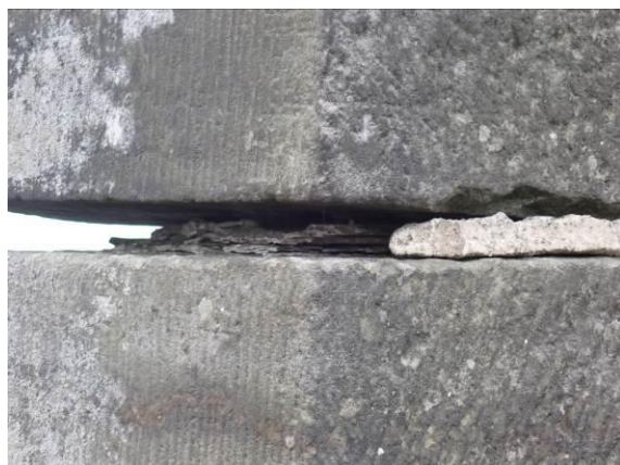
Geschädigter Setzmörtel
