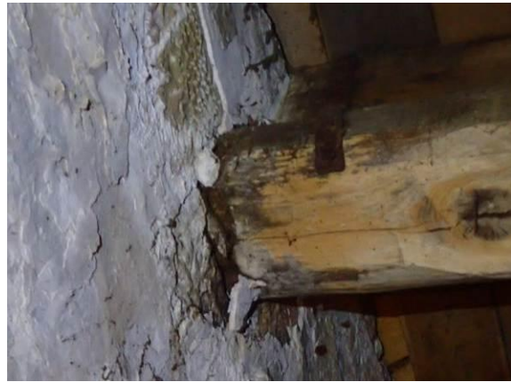
Geschädigtes Wandauflager
