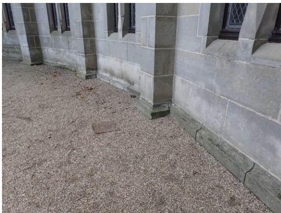
Sockel der Ostfassade
