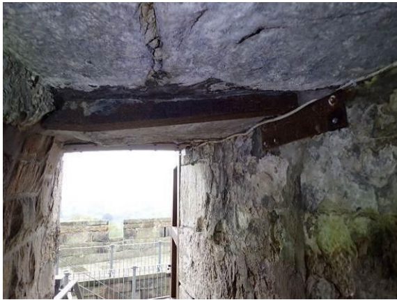
Sicherung Steinbalken, Eingang Süd
