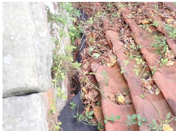
Abgängiger Anschluss im Detail
