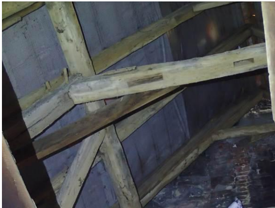
Unterdach Nordflügel, Kronenburg
