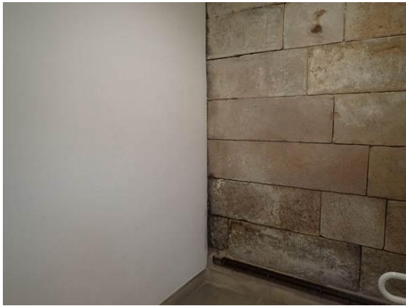
Erdgeschoss, Ecke Südost
