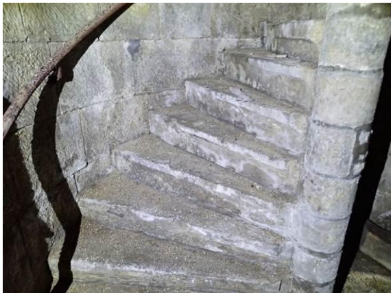
Unterer Bereich der Spindeltreppe
