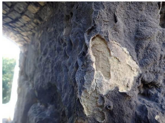
Verkrustung durch Bindemittelauswaschungen
