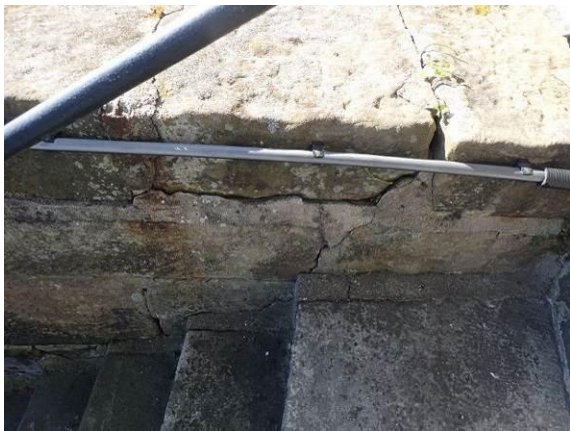
Verformte Mauerwerksschalen
