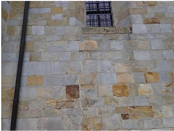
Brüstung Schiff, Südfassade
