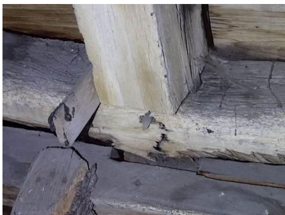
Gebrochene Sparrenschwelle
