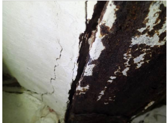
Schädigung Kappenträger
