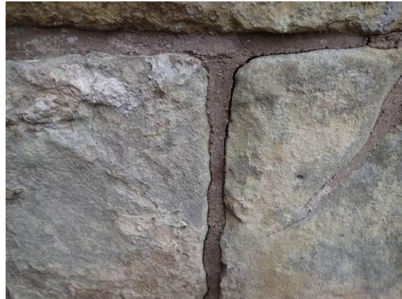
Separierte Fugenerneuerung
