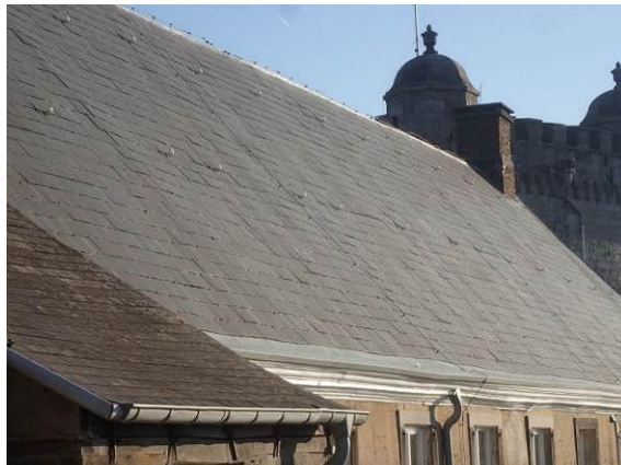
Verformung Dachfläche
