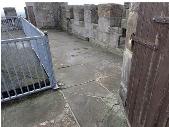
Verformter Belag auf dem Platon
