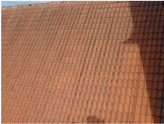
Teilansicht Dachfläche Süd
