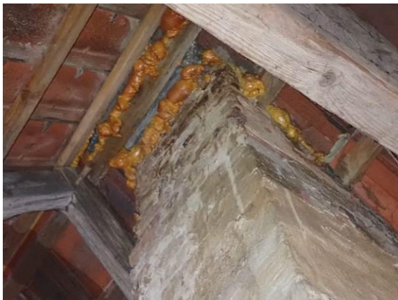
Abdichtungsversuch am Schornstein
