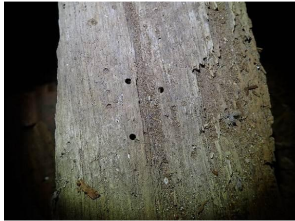
Ausflugslöcher im Detail
