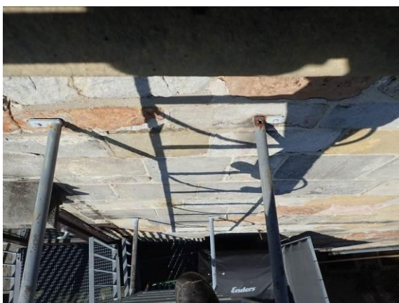
Fluchttreppe Dachgeschoss, Südfassade
