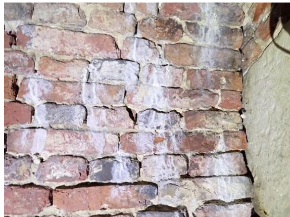
Bindemittelauswaschungen im Detail
