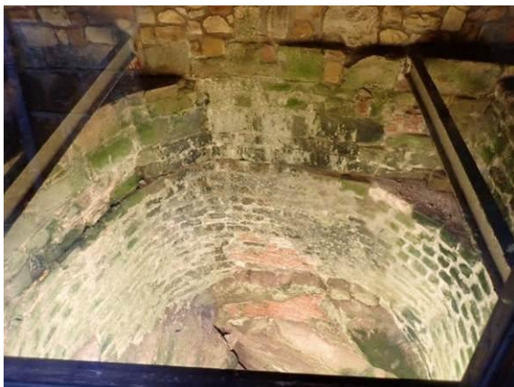
Aussteifungsträger im Brunnenhaus
