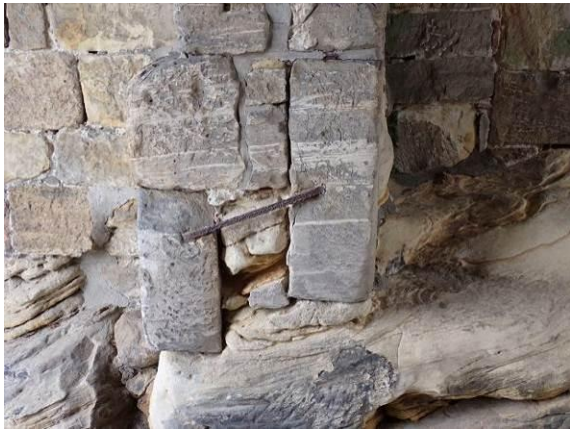
Sicherungsklammer Schalenmauerwerk
