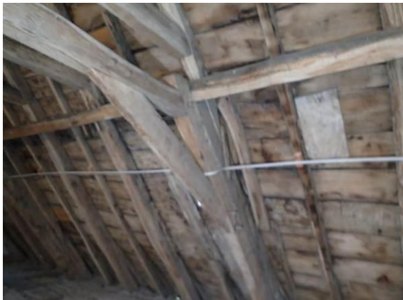
Zwischensparren ohne konstruktive Einbindung
