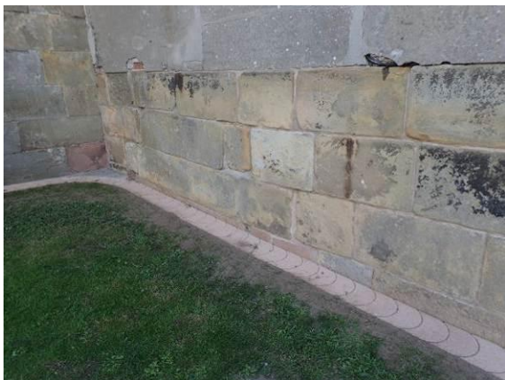
Verformung Ostfassade
