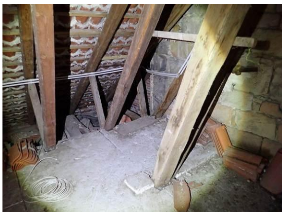
Knotenpunkt Nordost, Schiff
