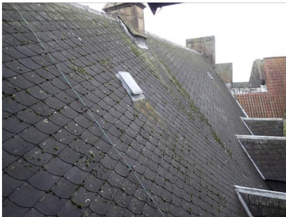
Teilansicht Dachfläche Ost
