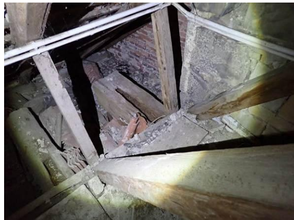
Nordauflager Deckenbalken Ost, Schiff
