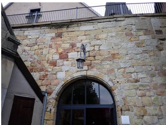
Teilbereich der Westfassade, Schiff
