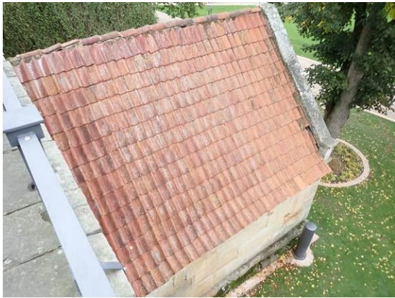
Ansicht Dachfläche Nord
