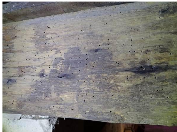
Ausflugslöcher nahe dem Auflager
