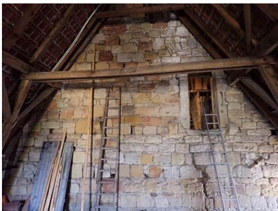
Teilbereich Westwand, Turm
