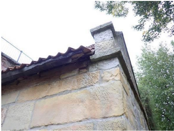
Dachanschluss zum Giebelschild
