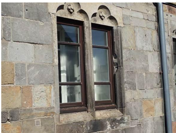
Fenster der Südfassade
