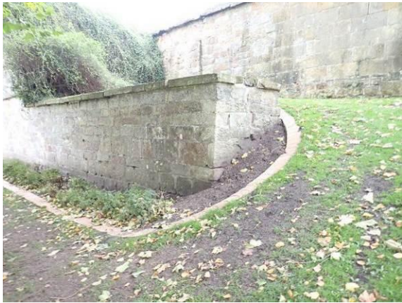
Flügelmauer Brunnenhaus Ost
