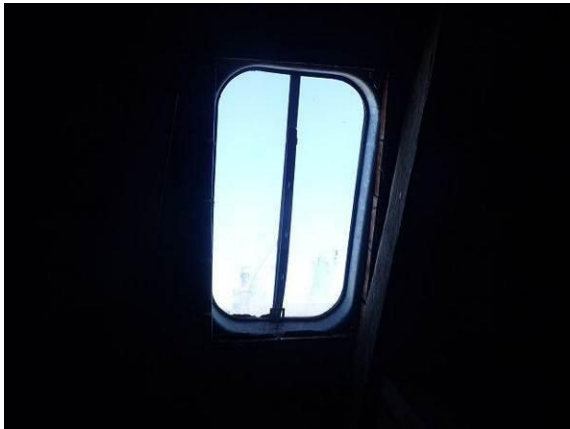
Dachfenster des Batterieturms
