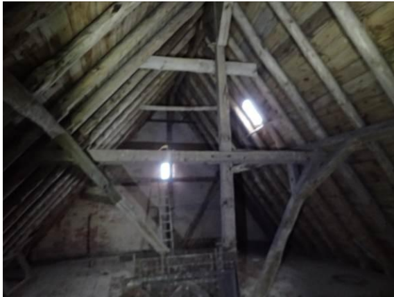
Dachtragwerk des Westflügels
