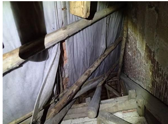
Zustand des Unterdaches im Detail
