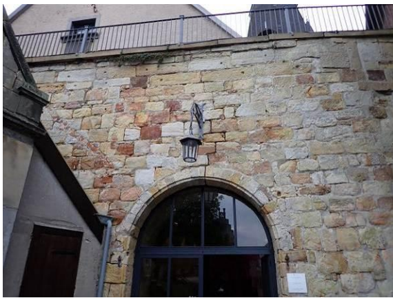
Teilbereich der Westfassade
