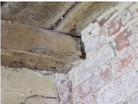
Geschädigtes Balkenauflager
