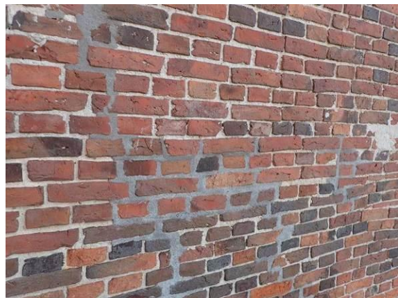
Zementöse Reparaturfugen
