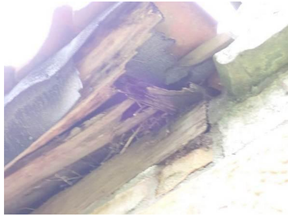
Schädigung Sparrenfuß
