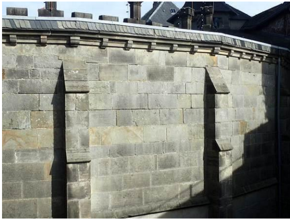
Teilbereich der Westfassade
