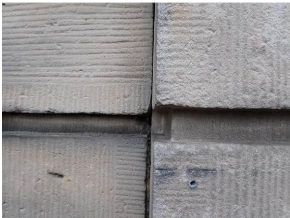
Fehlende Verzahnung zum Wiederlager
