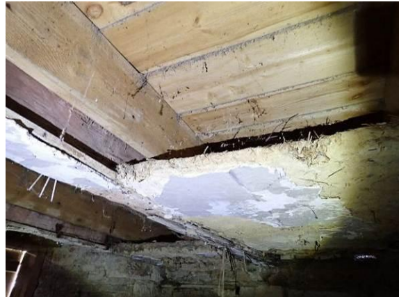
Zustand im Detail
