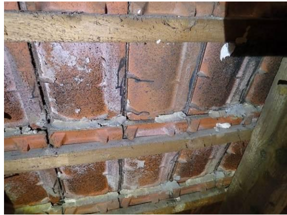
Geschädigter Mörtelverstrich
