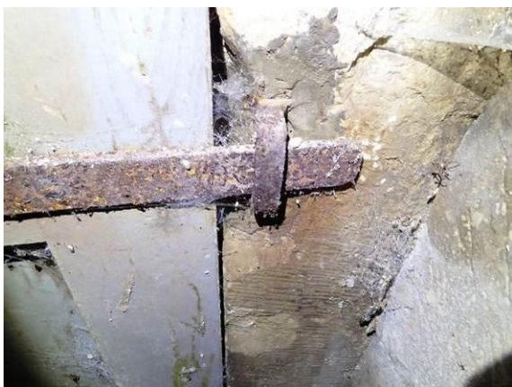
Korrosion Verriegelung
