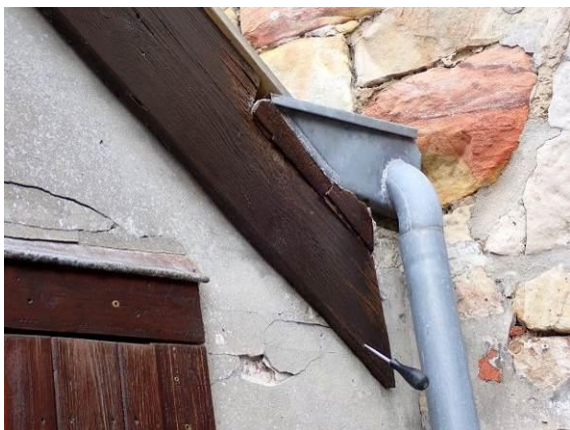
Stirnbrett am Ortgang, ehemaliges Kassenhaus
