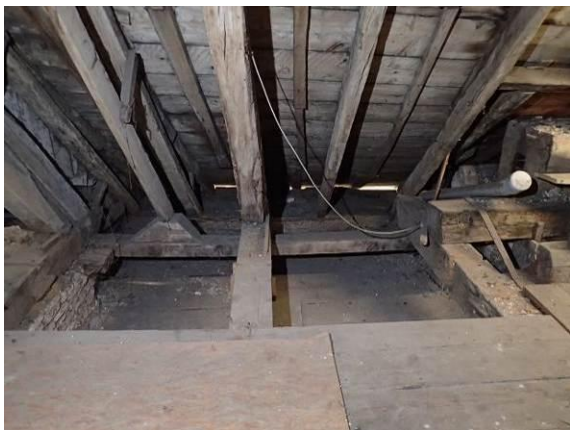
Aufsattelung Schleppdach im Detail
