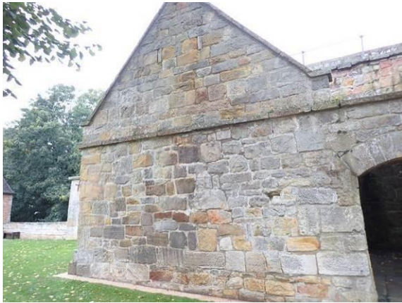
Südfassade des westlichen Brunnenhauses
