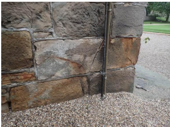
Sockelbereich des Südflügels
