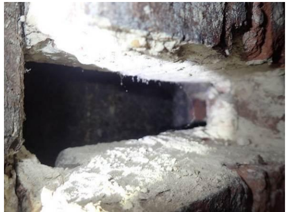
Bauteilöffnung in der Vorsatzschale
