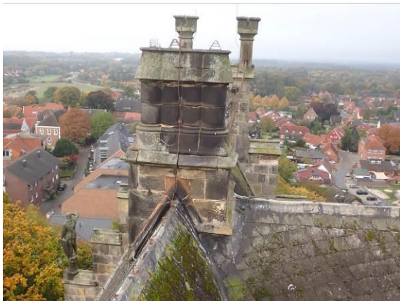
Ansicht Schornsteinkopf, Südflügel
