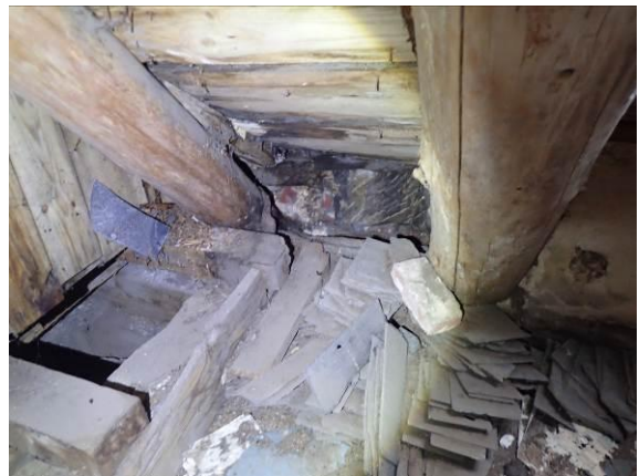
Schädigung Sparrenfuß
