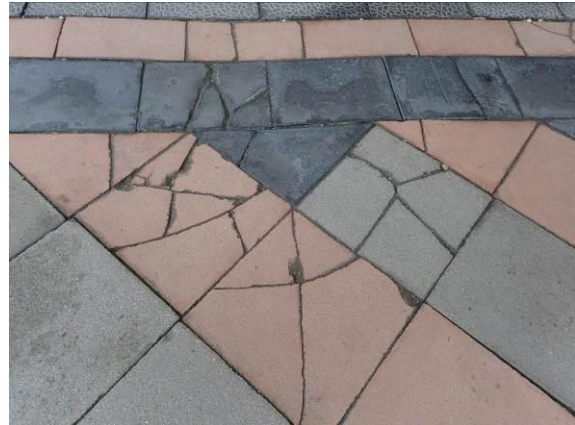
Schädigung Bodenbelag
