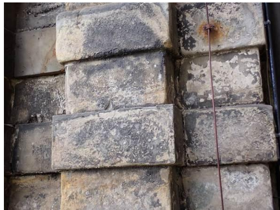
Oberflächenverluste durch Mürbzonenbildung
