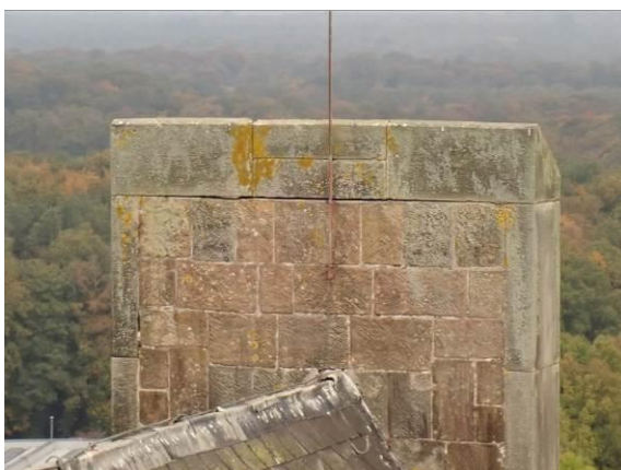
Korrodiertes Zugband
