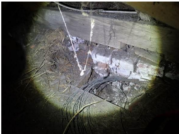
Geschädigter Balkenkopf
