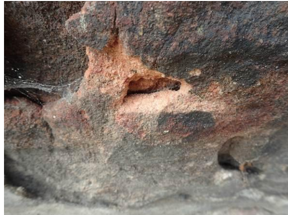
Oberflächenverlust durch Bindemittelabbau
