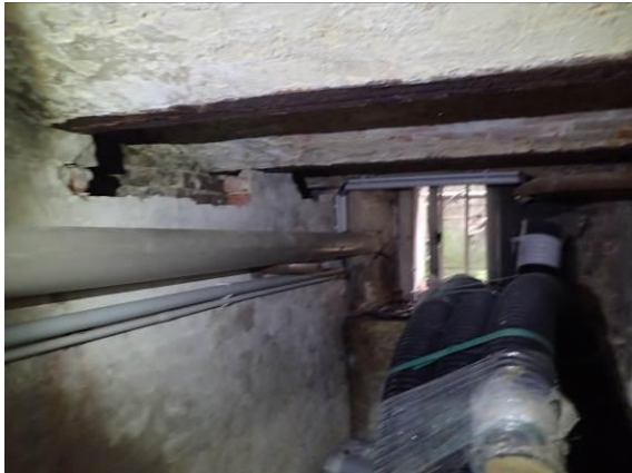
Kappendecke im Südflügel, KG
