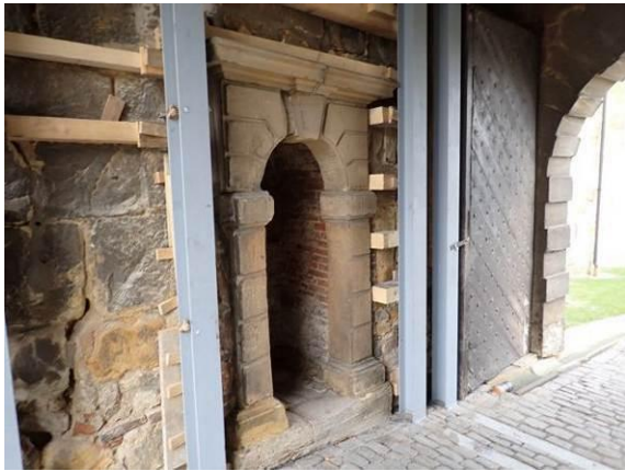
Teilansicht Wiederlagerwand Nord
