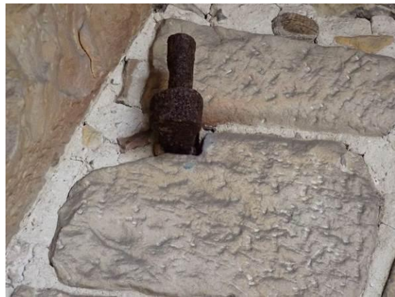
Korrodierter Kloben
