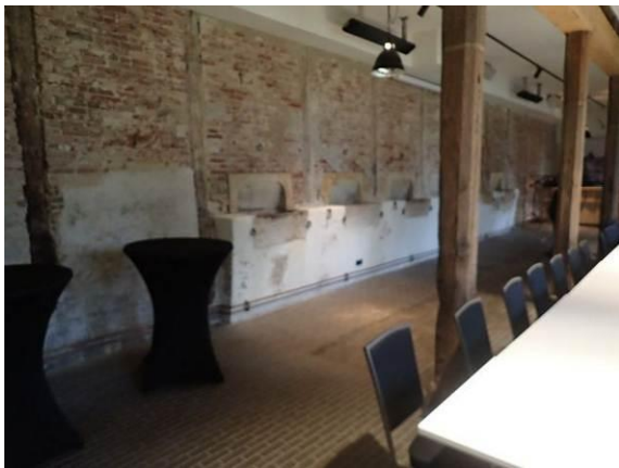
Vorsatzschale vor der Südwand
