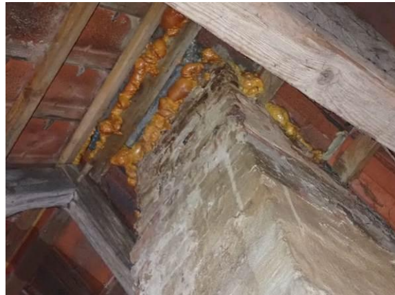
Abdichtungsversuch am Dachanschluss
