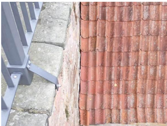
Anschluss zur oberen Wehrmauer
