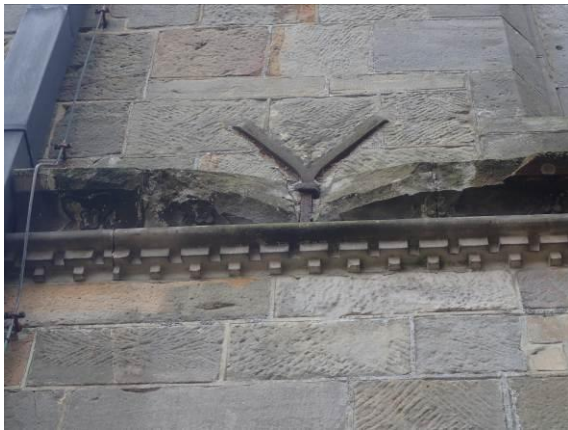
Maueranker des Südflügels
