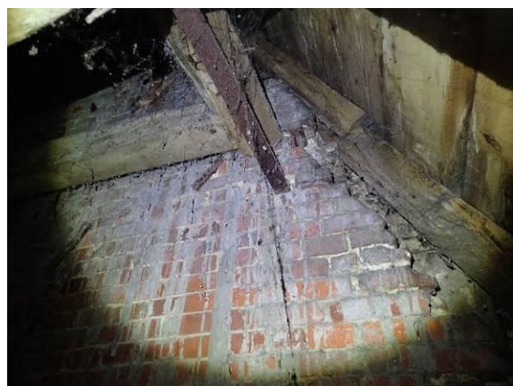
Auswaschungen im Giebelschild
