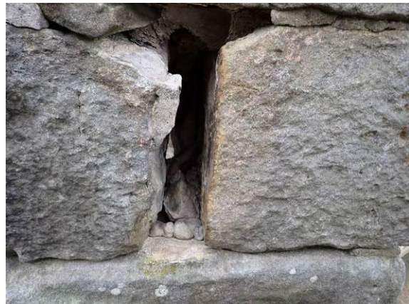
Zustand des Kernmauerwerks im Detail
