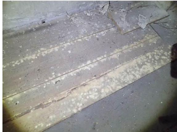
Bohrmehlhaufen im Detail
