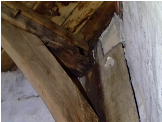
Balkenaufleger am Eckständer
