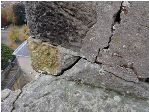
Überfugter Gefügeschaden
