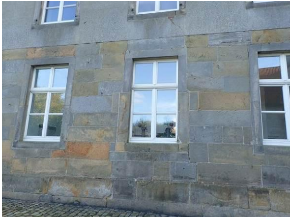
Teilbereich der Nordfassade
