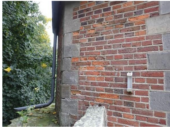
Ablastung im Detail
