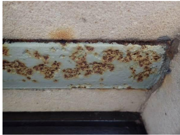
Korrosion Sturzträger
