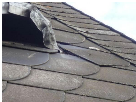
Eindichtung Lüftungsgaube im Detail
