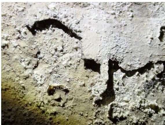
Ablösung Bestandsoberfläche
