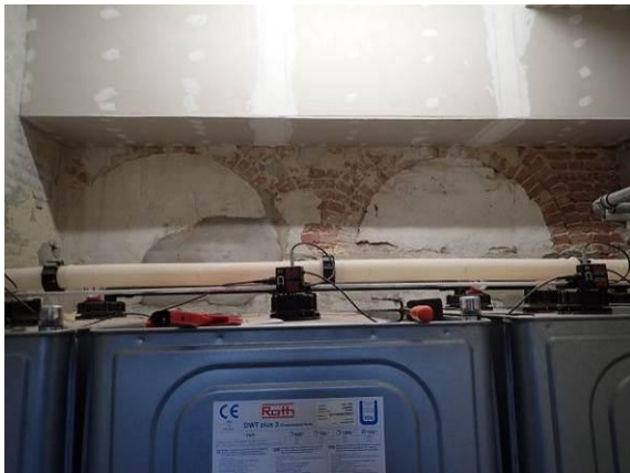
Akardenbögen vor der Südwand, Erdgeschoss
