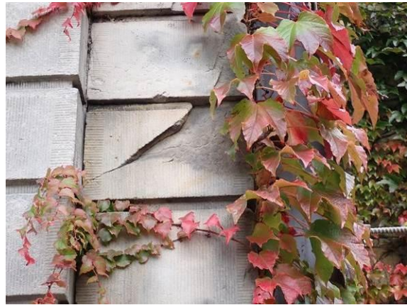
Steinsprengung im Wiederlager
