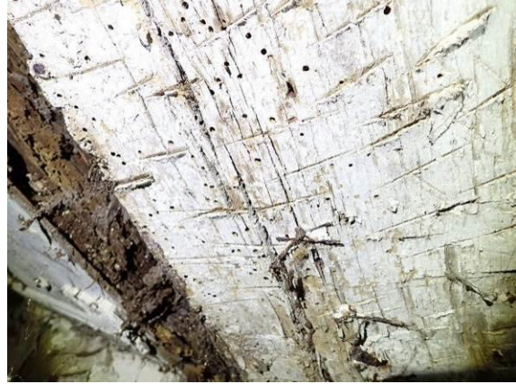
Untersicht Schwellbalken Südflügel
