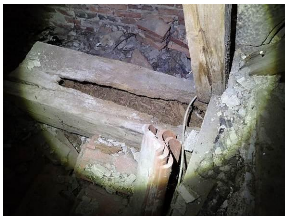
Ablastung im Detail
