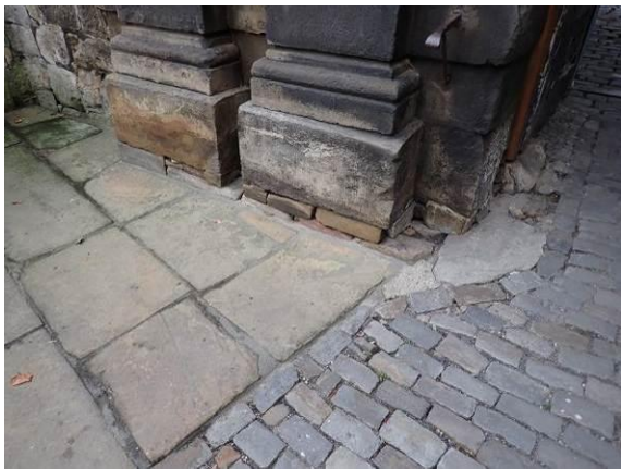
Zustand im Sockelbereich
