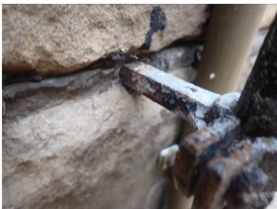
Korrosionssprengung Blitzschutzhalter
