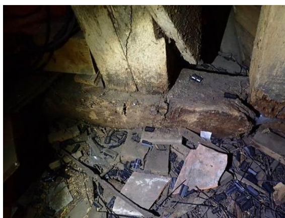
Schädigung Dachbalken
