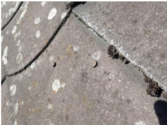
Gelöste, direkte Nagelverbindung
