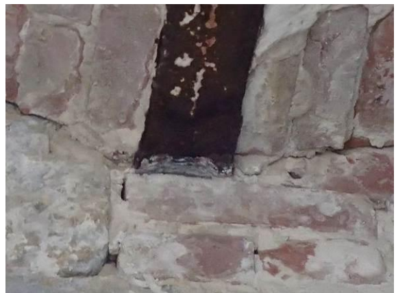
Kappenträgerauflager in der Werkstatt
