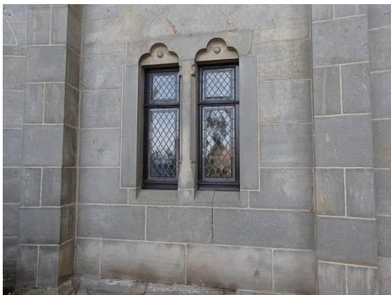
Rissbildung in einer Fensterachse
