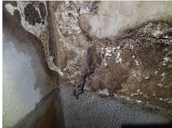
Materialumwandlung eines Kellerinnenputzes
