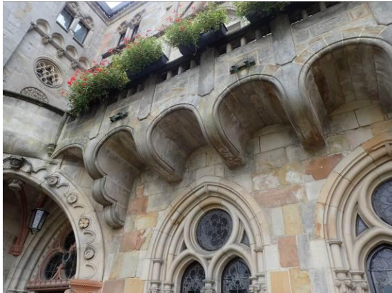
Balkon Ostfassade, Kronenburg
