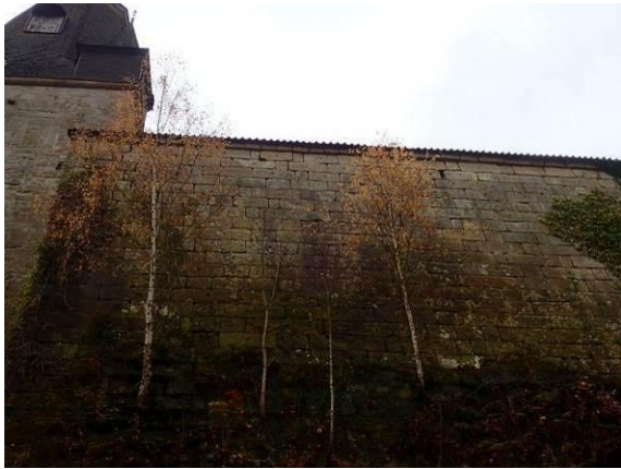
Nordfassade der Katharinenkirche
