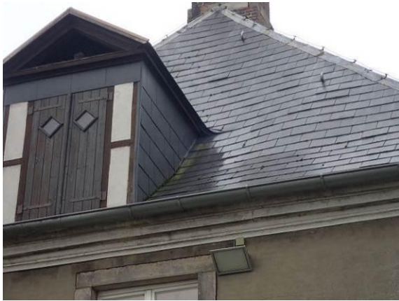
Anschluss Satteldachgaube Ost
