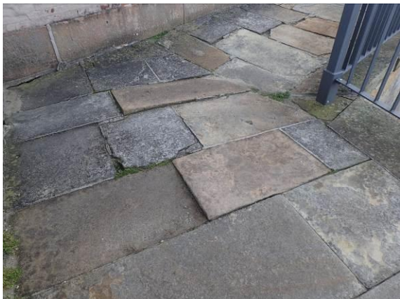
Verformter Plattenbelag
