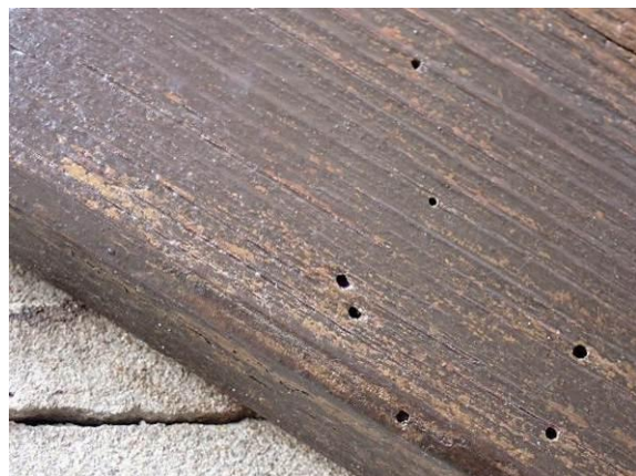
Ausflugslöcher im Detail
