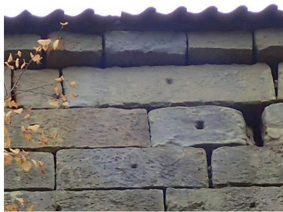
Lockerungen im Traufbereich
