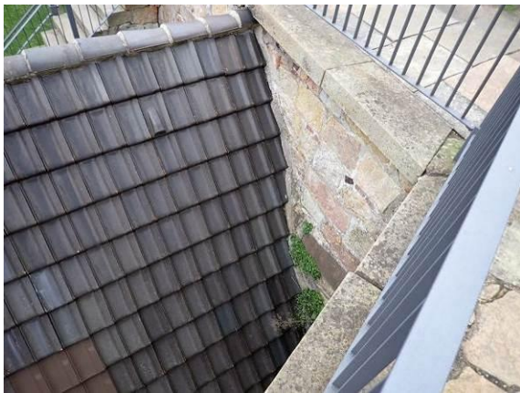
Geschädigter Mörtelschlag
