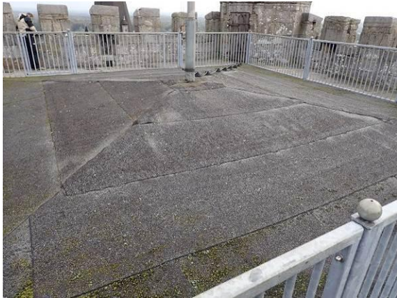
Dachhaut des Pulverturms
