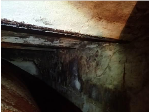
Kappenträger im Keller, Südflügel
