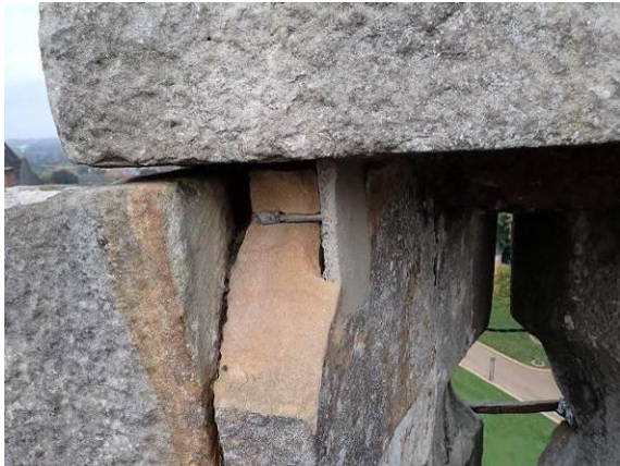
Abgängiger Sicherungsversuch
