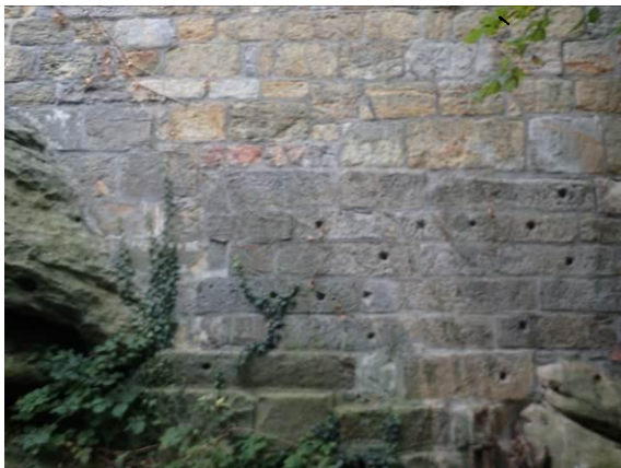
Sockelbereich der Kronenburg
