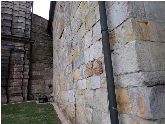
Brüstungsbereich der Südfassade
