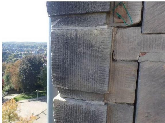
Gelöster Ankerstein am Süderker
