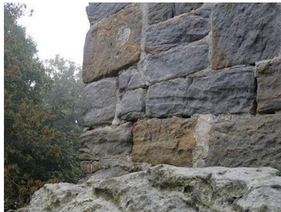
Lockerung im Detail
