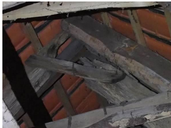
Geschädigter Firstpunkt
