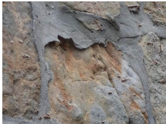
Steinzerfall unter einer zementösen Anstragung
