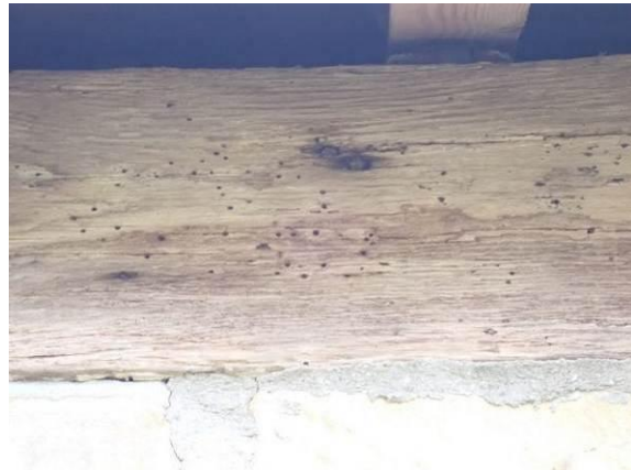
Ausflugslöcher im Detail
