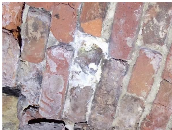
Kalksinterkruste im Detail
