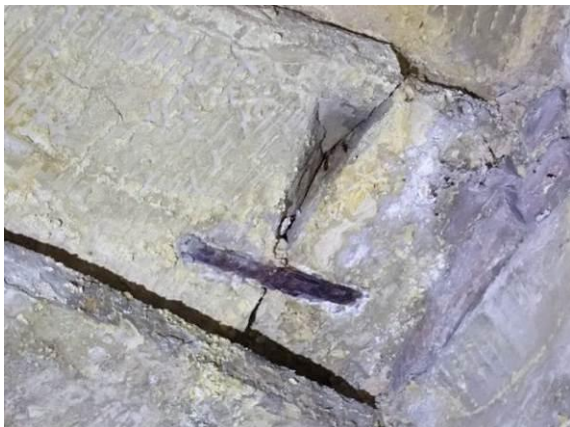
Korrosion Sicherungsklammer
