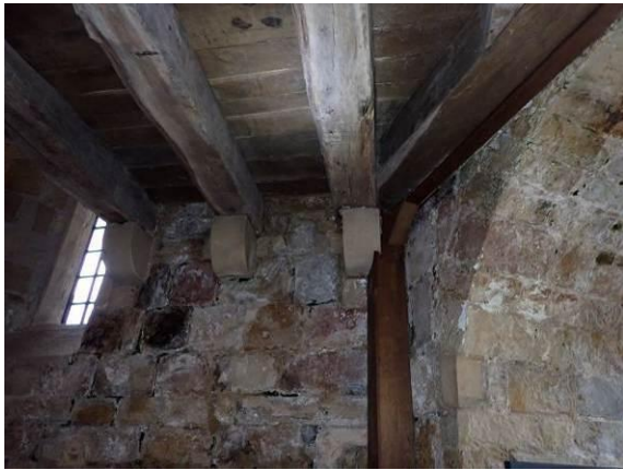
Teilansicht Innenecke Südwest
