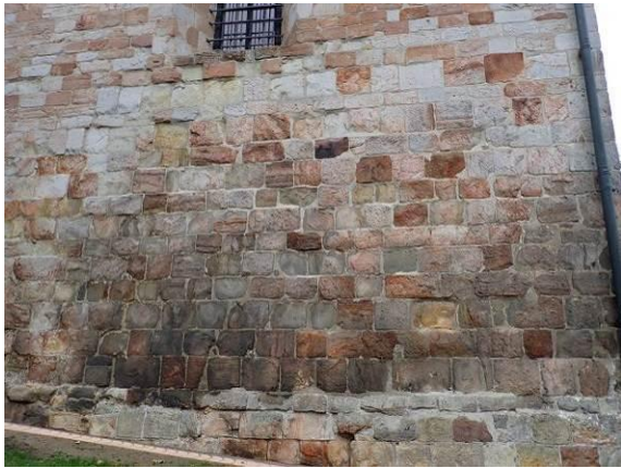
Teilbereich Ostfassade, Turm
