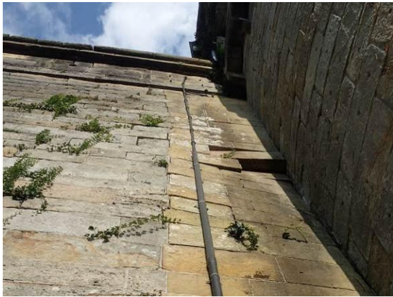
Schachtmauerwerk am Batterieturm
