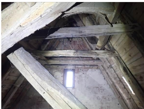
Teilansicht Dachtragwerk, Südflügel
