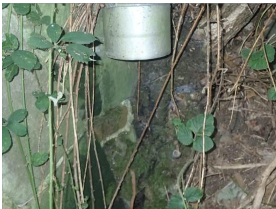
Fehlender Fallrohranschluss
