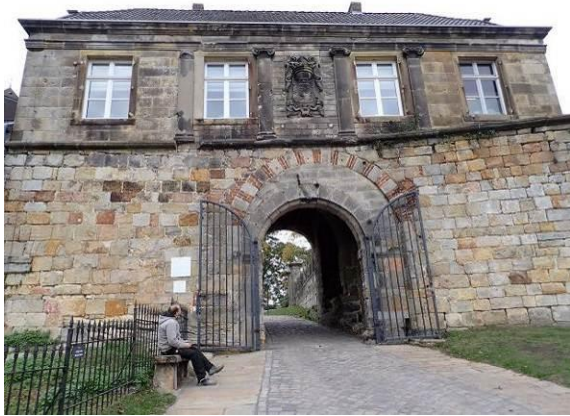
Südfassade des unteren Torhauses
