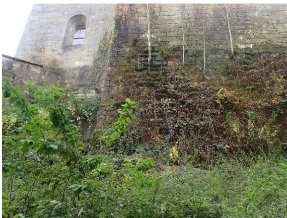
Sockelbereiche des Schiffes
