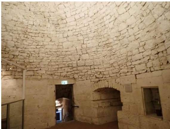
Teilbereich des Kuppelgewölbes
